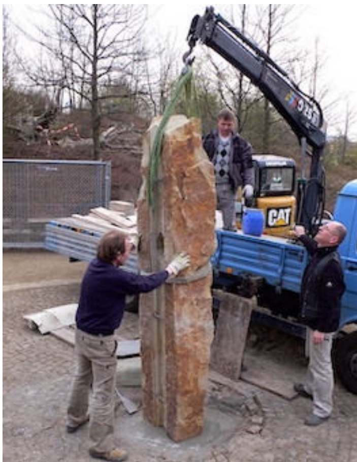
Errichtung des 'Sprechenden Steines' mit Bezug auf die 'Gesteine Südniedersachsens' am Ginkgo-Hügel
